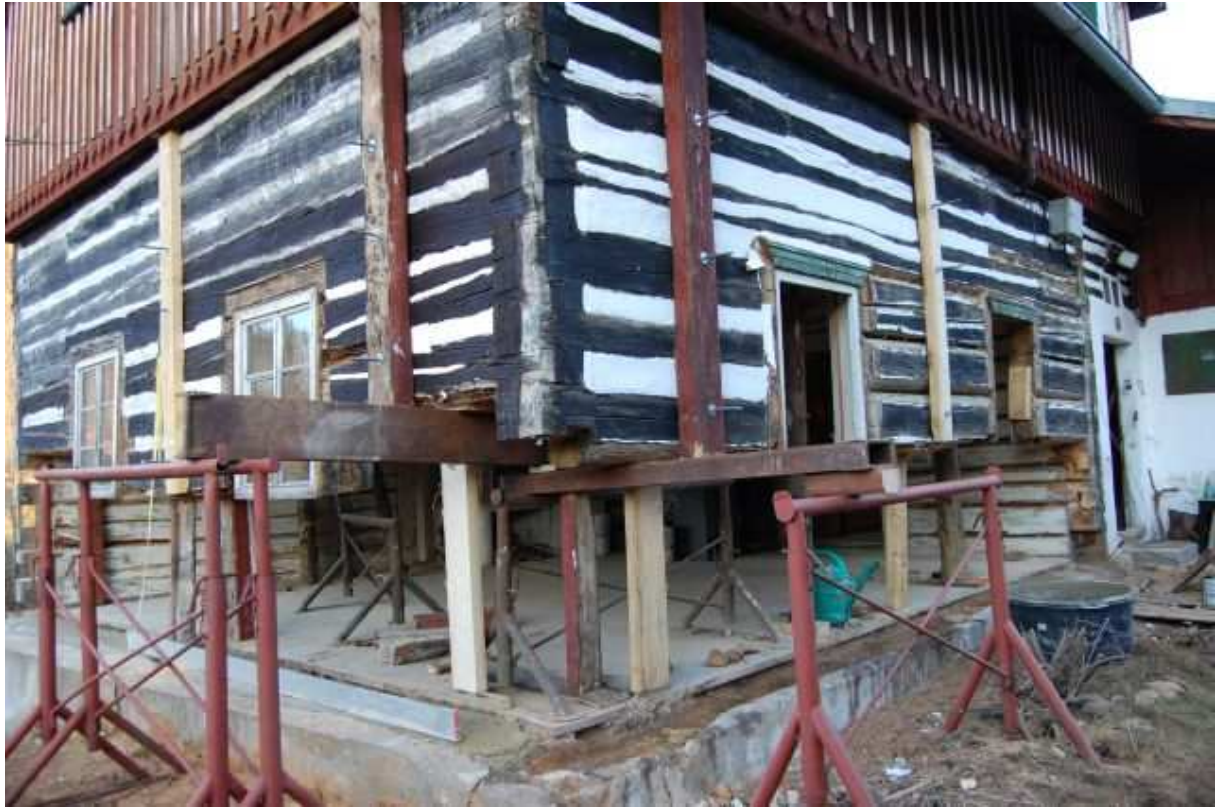
Příklad výměny spodních trámů – realizace M. Kirschner
