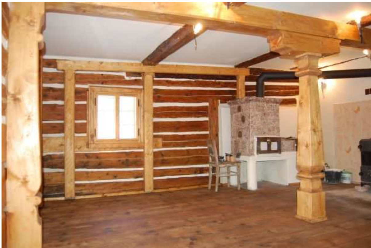
Příklad realizace výměny spodních trámů, podchycení stropu a celková rekonstrukce světnice – Matouš Kirschner
